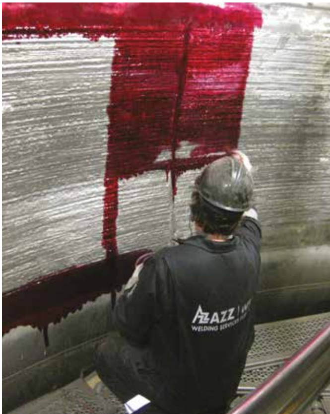
Inspeção por LP da solda de revestimento
