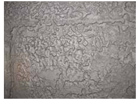
Corrosão/erosão
