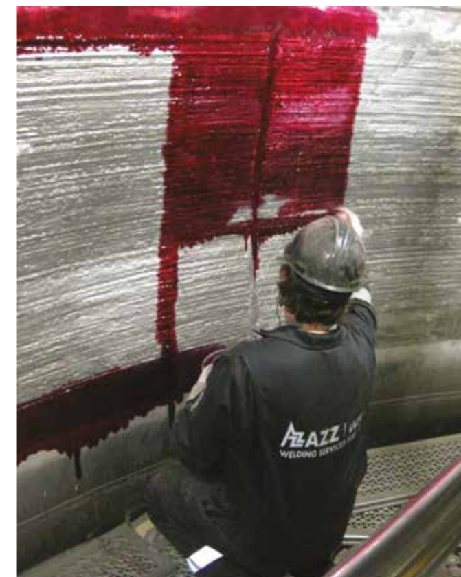
PT-Inspektion der Auftragsschweißung
