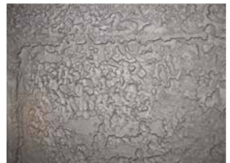
Corrosión/erosión
