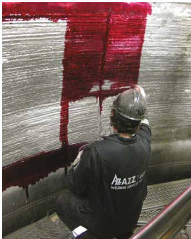
Inspección PT del recargue con soldadura
