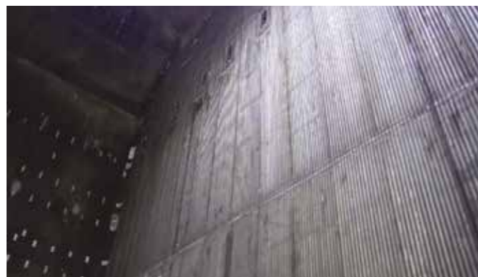
O reparo da AZZ/WSI com Unifuse 622 prolonga a vida útil da caldeira a carvão
