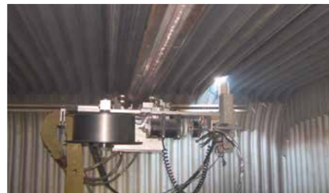
Se o dano é extenso, uma solda de revestimento automática deve ser realizada para reestabelecer a espessura de revestimento requerida
