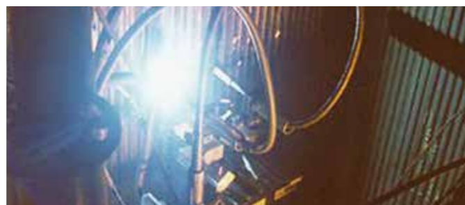
Reparo em campo de uma caldeira de recuperação de lixívia negra
