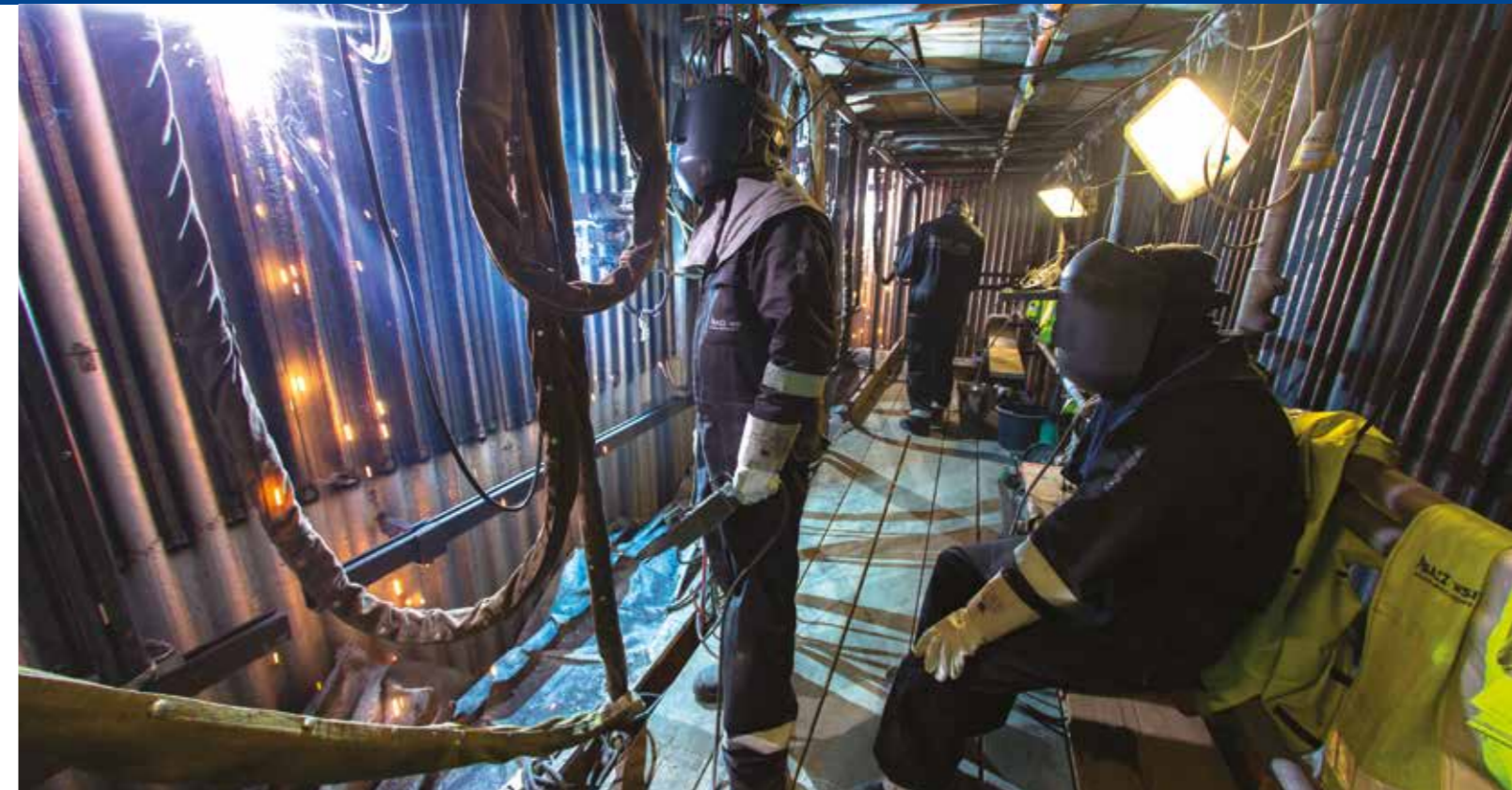
Rohrwandreparatur in einer Müllverbrennungsanlage
