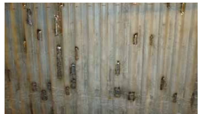
Punktuelle Ausbesserungen an einer alten 625 Auftragschweißschicht
