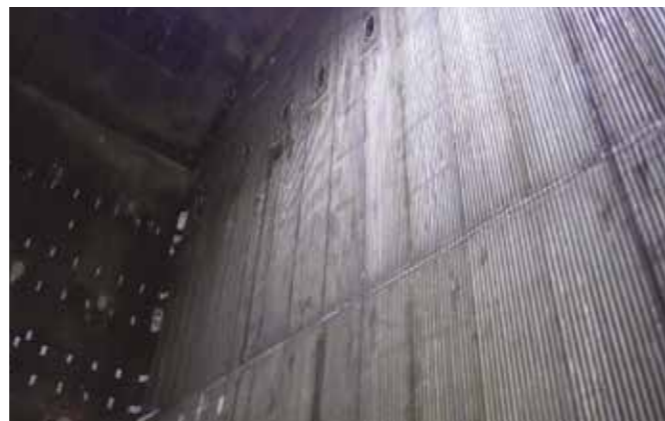
Reparaturen von AZZ WSI mit Unifuse 622 verlängern die Lebensdauer des kohlebefeuernden Kessels
