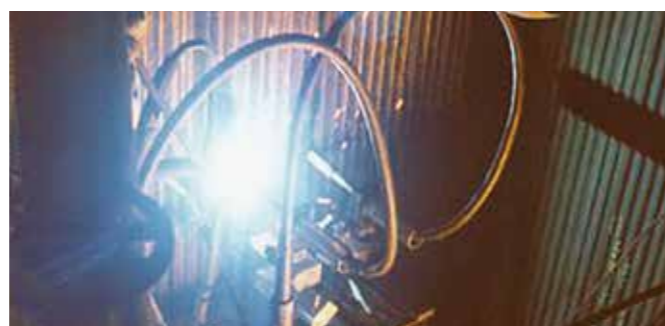
Vor-Ort Reparatur an einem Kessel zur Rückgewinnung von Schwarzlauge
