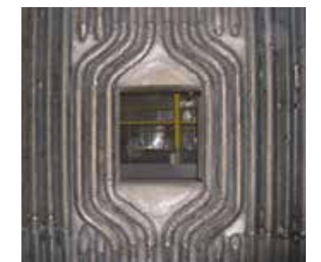
Plattierte Membranwand mit Ausbiegungen
