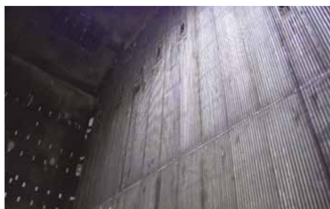
La riparazione da parte di AZZ WSI con Unifuse 622 ha allungato la vita utile della caldaia a carbone.
