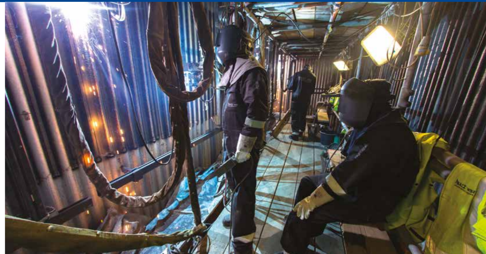
Riparazione pareti membranate presso un Impianto di Recupero Energetico
