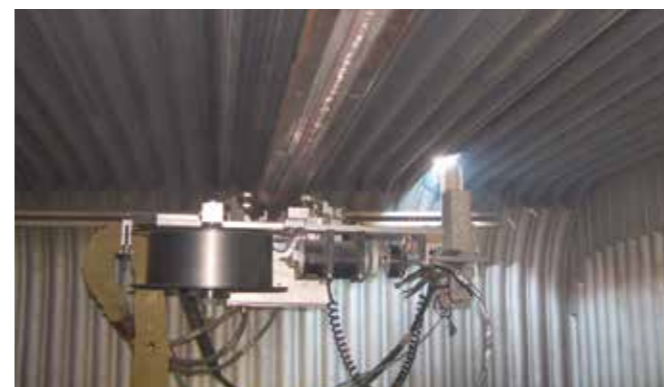
Se il danno è esteso, si deve applicare un riporto di saldatura Unifuse automatico per ripristinare lo spessore richiesto del riporto di saldatura.
