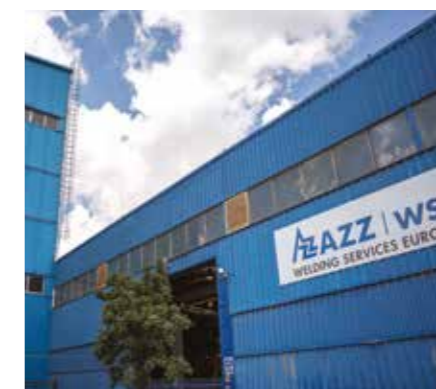
Il nostro stabilimento di produzione di Radom (Polonia) lavora 24 ore su 24, 7 giorni su 7
