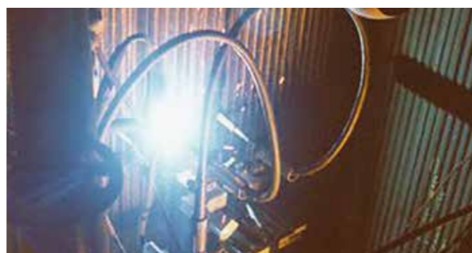
Riparazione in campo di una caldaia a recupero di liquor nero
