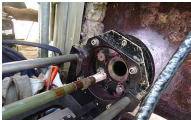
Reparación automatizada de tubuladuras en campo
