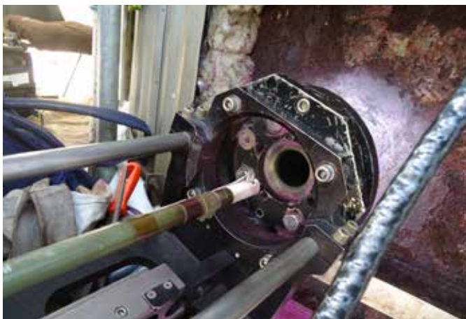
Réparation In Situ d'un piquage de réacteur
