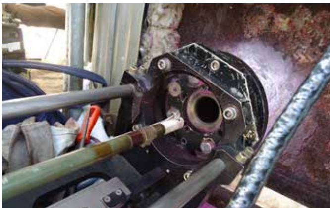
Automatisierte Vor-Ort-Reparatur von Stützen
