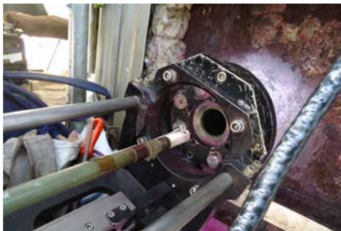
Reparo automatizado de bocal em campo
