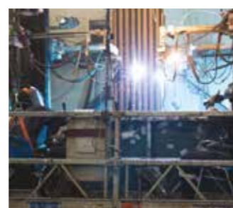
Revestimento de painel
