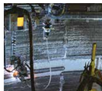
Revestimento com Liga Resistente a Corrosão por meio de soldagem
