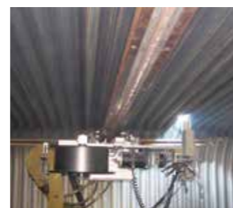
Revestimento de parede d'água
