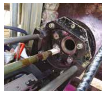
Revestimento de bicos
