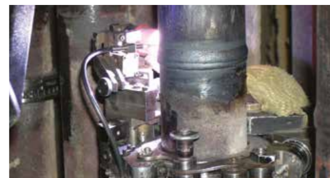
Soldadura orbital en tuberías
