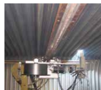
Recargue de paredes de agua
