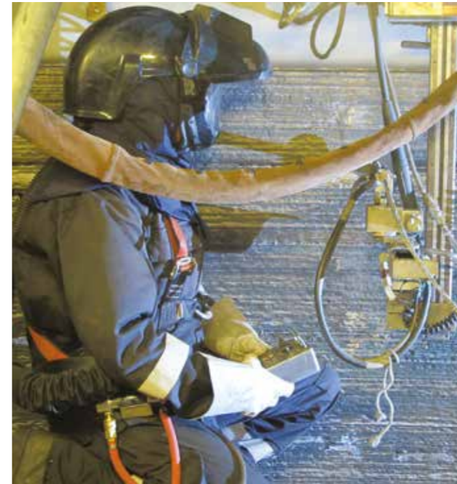
Operarios equipados con EPIs necesarios
