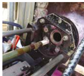
Recargue interior de tubuladuras
