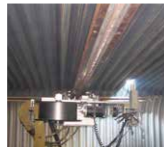
Auftragsschweißung an Wasserwänden
