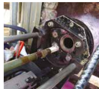
Auftragsschweißung an Stützen
