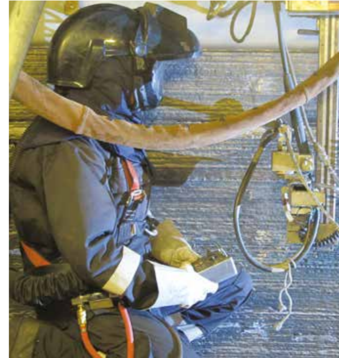
Gli operatori sono completamente equipaggiati con gli strumenti necessari di sicurezza
