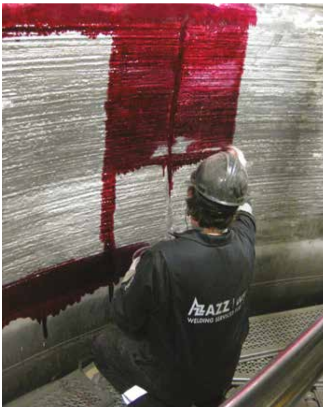
Ressuage (PT) du rechargement
