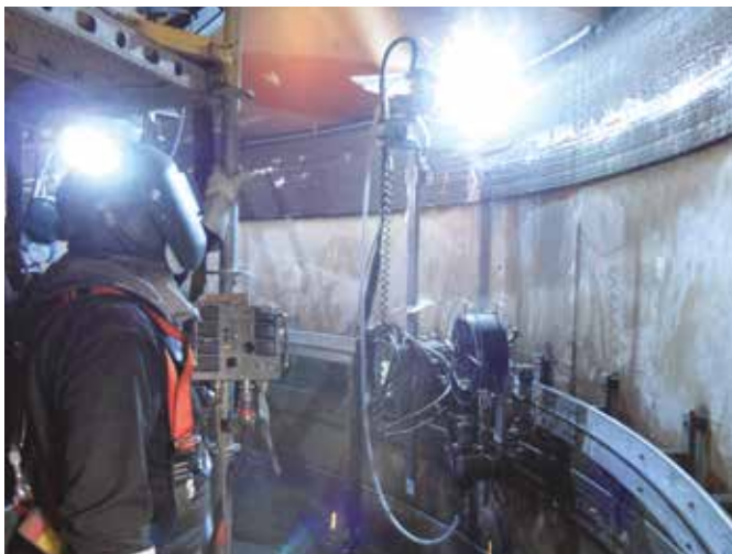
El personal está equipado con los materiales de seguridad necesarios
