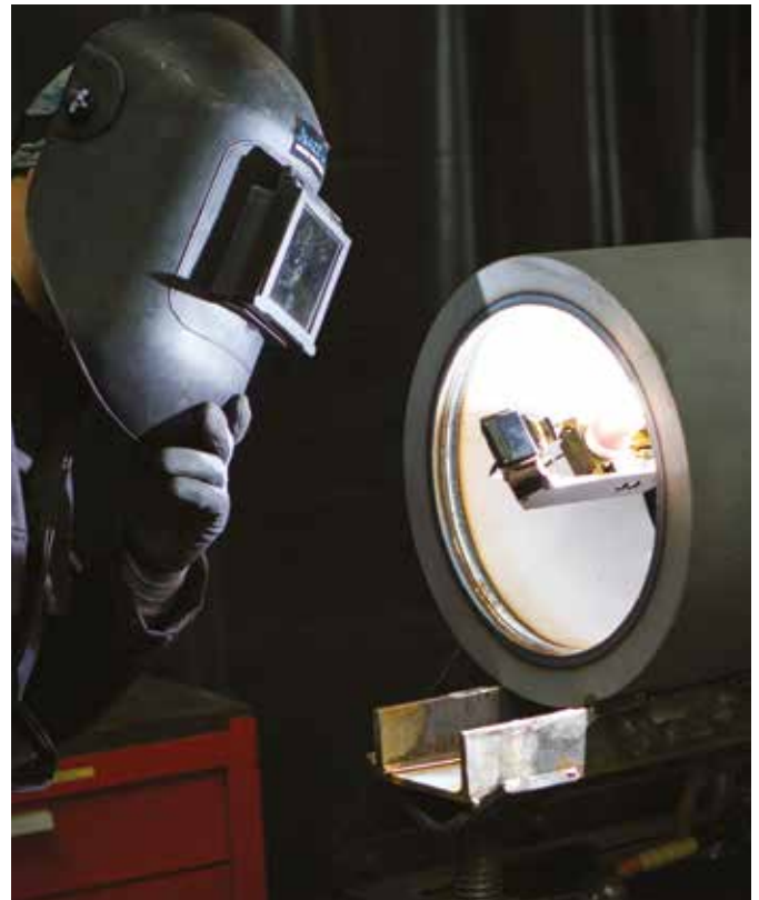
AZZWSI ofrece una solución de reparación totalmente automatizada para un diámetro de inyector desde 2” hasta tubuladuras y bocas de hombre de 24”
