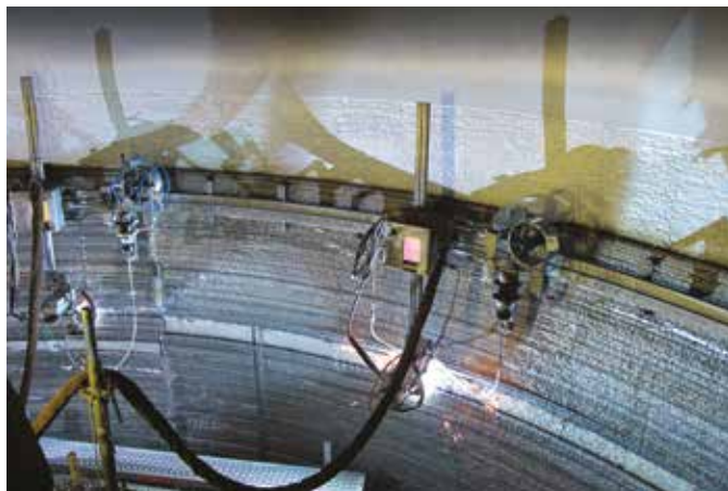
Recargue con soldadura automatizada utilizando el proceso Unifuse
