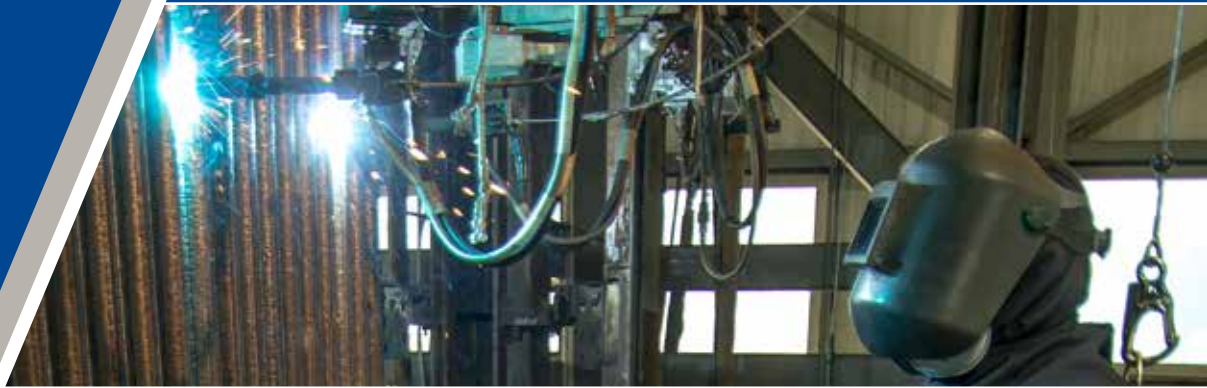
Painel na fixação
