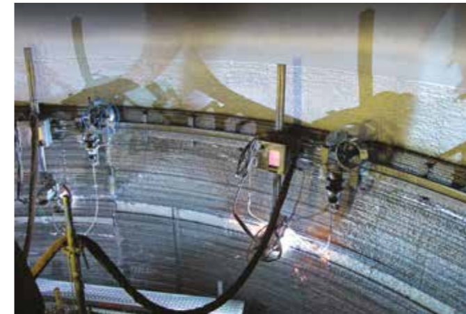
Recubrimiento con soldadura automatizada utilizando el proceso Unifuse
