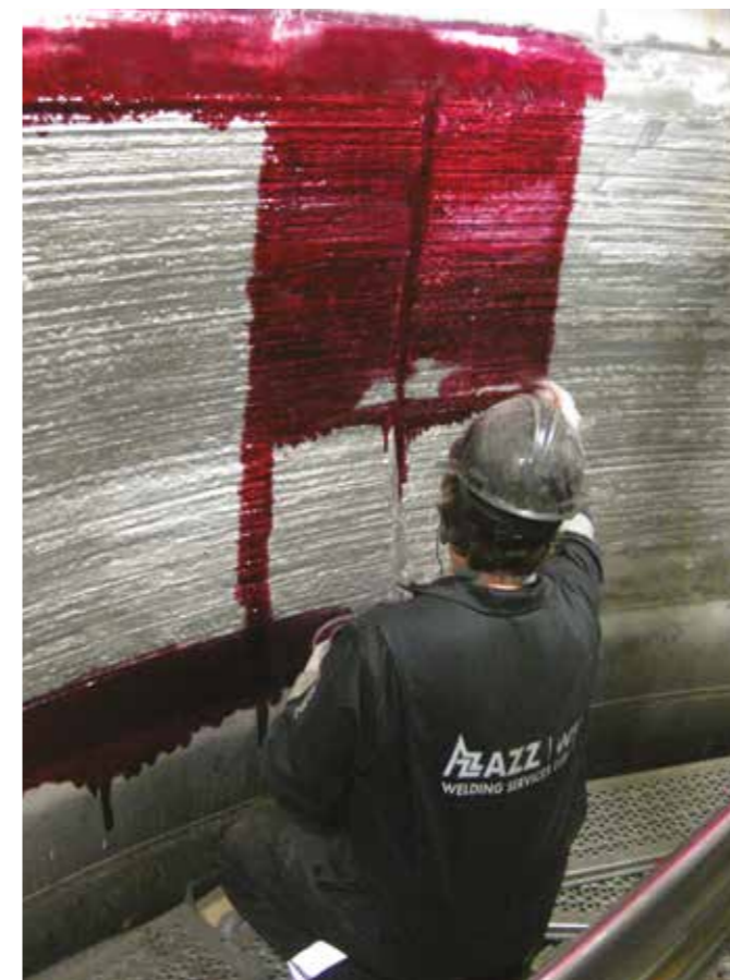
Inspección PT del recubrimiento con soldadura
