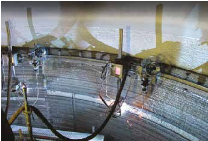
Rechargement par soudage automatisé via le processus Unifuse
