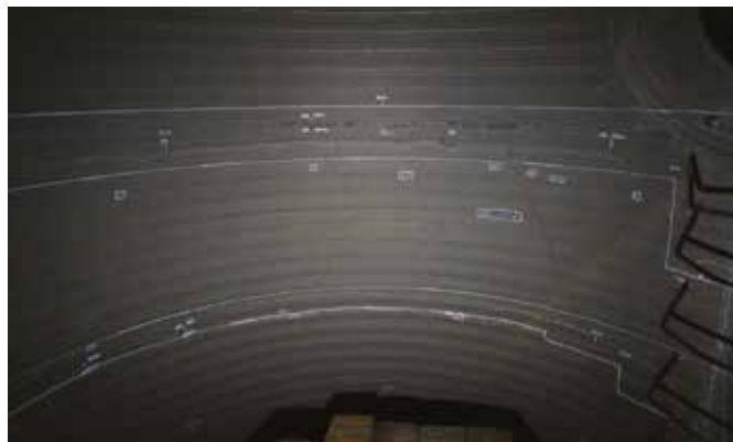
Inspection sur site préalable au chantier
