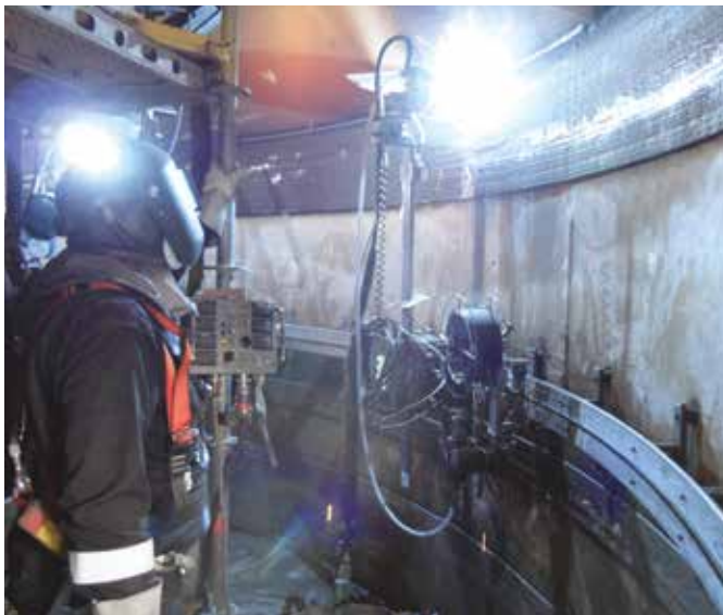
Personnel équipé de tout le matériel de sécurité nécessaire
