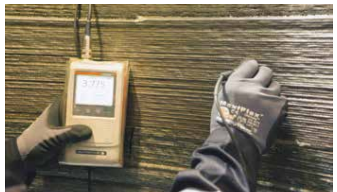
Letture UT dello spessore del rivestimento
