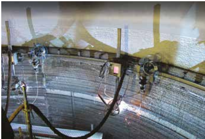
Riparto di saldatura automatica con il processo Unifuse
