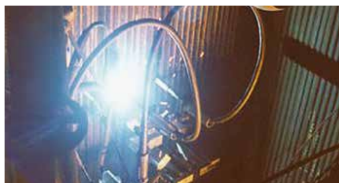
Réparation d'une chaudière à récupération de liqueur noire sur site
