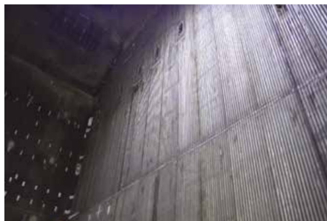
La réparation d'AZZ WSI avec Unifuse 622 a permis de prolonger la durée de vie de la chaudière à charbon
