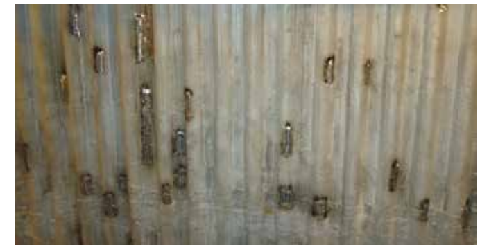
Réparations partielles sur un ancien rechargement par soudure à l'alliage 625
