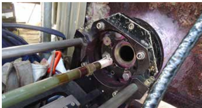
Reparación automatizada de boquillas en campo
