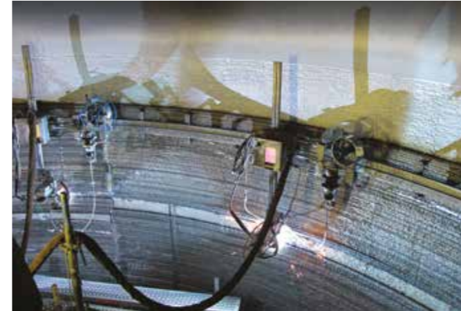
Automatisierte Auftragschweißtechnologie nach dem Unifuse -Verfahren
