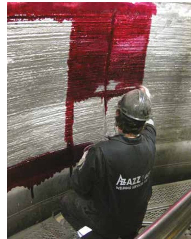
PT-Inspektion der Auftragsschweißung
