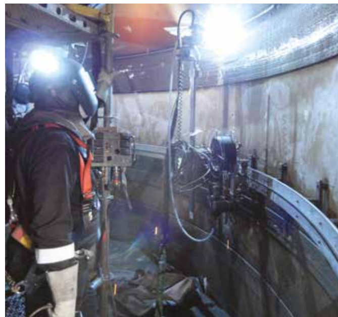
El personal está equipado con los materiales de seguridad necesarios
