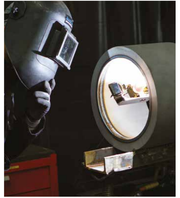
AZZ WSI ofrece una solución de reparación totalmente automatizada para un diámetro de interior desde 2" hasta boquillas y bocas de hombre de 24"
