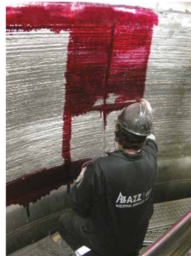
Inspección PT del recubrimiento con soldadura
