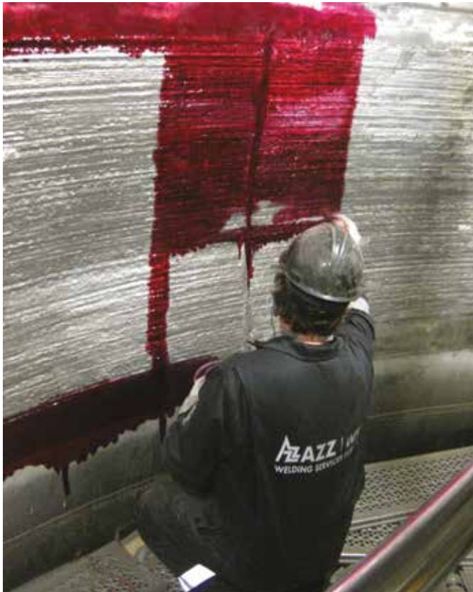
Inspeção por LP da solda de revestimento
