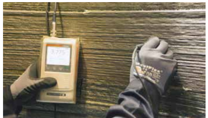
Medições de espessura
