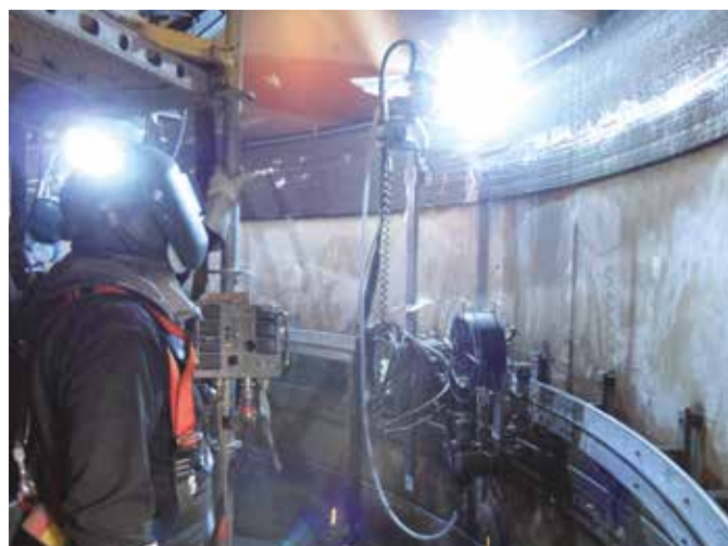
La forza lavoro è dotata di tutti i necessari dispositivi di sicurezza
