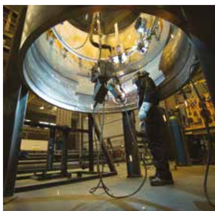
Mock-up per la saldatura di riporto automatico su superfici sferiche
